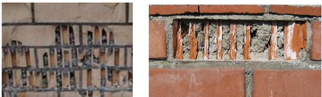
**Рисунок А.2.2.** Заполненные строительным раствором щели пустотных кирпичей
