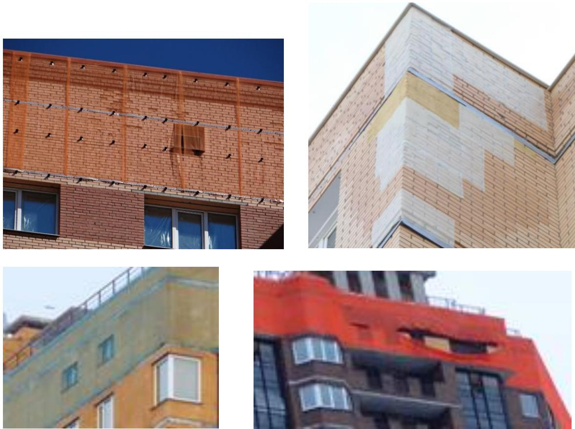
**Рисунок Б.10.** Установка защитных полимерных сеток, предотвращающих падение поврежденной кладки облицовочного каменного слоя без устранения причин повреждения и воостановления кладки
