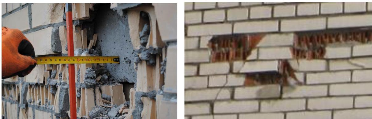
**Рисунок А.1.11.** Раздробление каменной кладки в уровне междуэтажных перекрытий с неполным опиранием облицовочного слоя (с транзитными участками) из-за отсутствия горизонтальных деформационных швов
