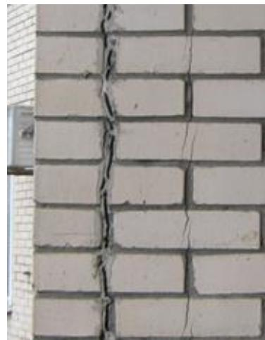
**Рисунок Б.2.** Герметизация трещин монтажной пеной или неатмосферостойкими мастиками
