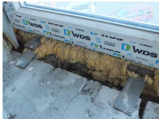
**Рисунок А.2.7.** Нарушение сплошности теплоизоляционного слоя в зоне примыкания окон
