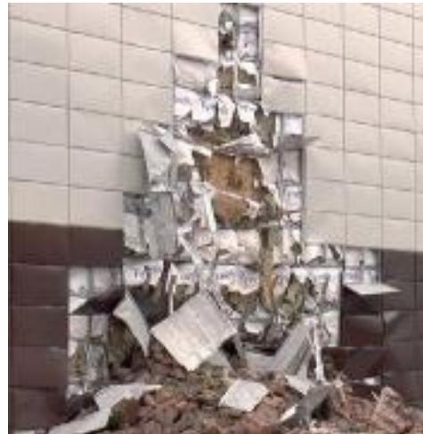
**Рисунок В.9.** Вывал фрагмента навесной фасадной системы с металлической облицовкой вследствие ненадежного крепления подоблицовочного каркаса к основанию (каменной стене)
