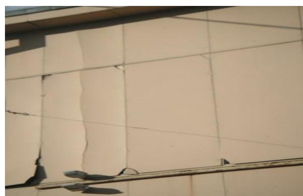
**Рисунок В.8.** Коробление и растрескивание фиброцементных плит из-за отсутствия температурных пазов в местах крепления к металлическим направляющим
