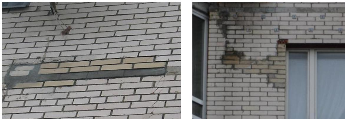
**Рисунок Б.4.** Ремонт облицовочного слоя с докомпактовкой (заменой) разрушенных участков кладкой, отличающейся физико-механическими свойствами и цветом от основной кладки, без устранения причины разрушений или усиления фасада
