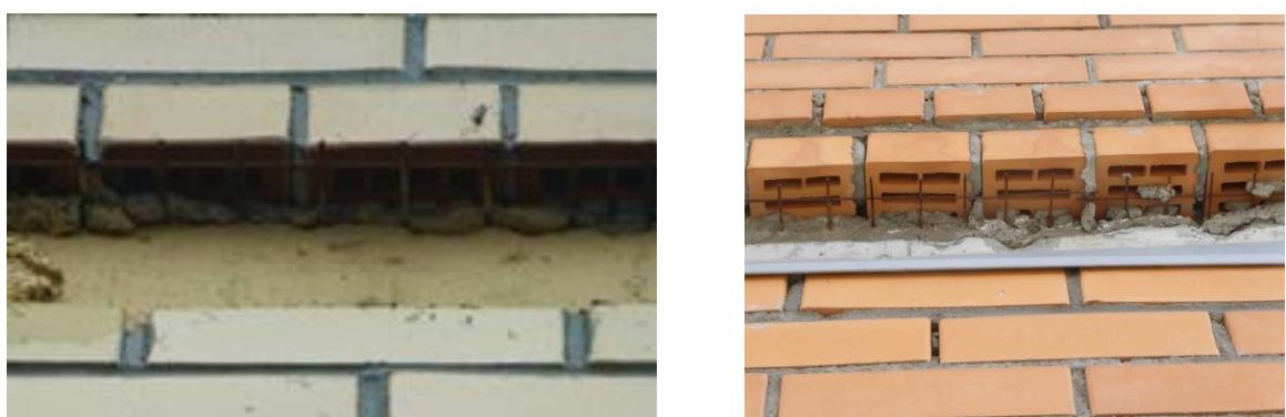
**Рисунок А.2.3.** Опирание облицовочного слоя на тычковые ряды без заполнения торцов плит перекрытий кирпичом и устройства отливов
