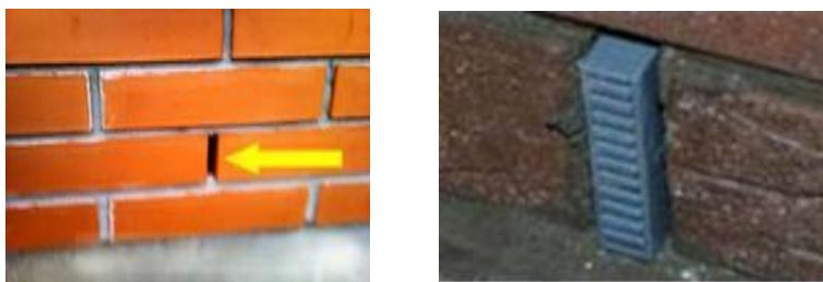
**Рисунок 13.2.** Устройство вентиляционных продухов в растворных швах
