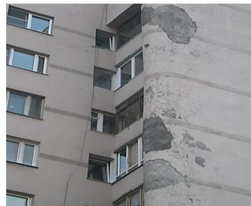
**Рисунок Б.6.** Оштукатуривание поврежденного облицовочного слоя
