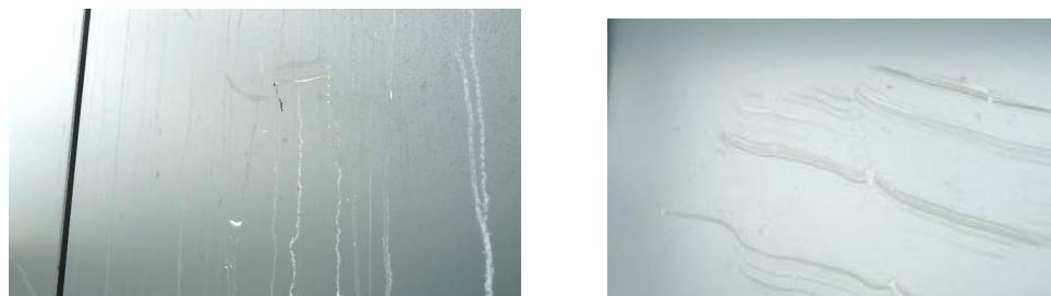
**Рисунок В.6.** Механические повреждения облицовочных металлических кассет
