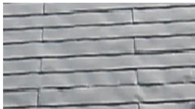
**Рисунок В.7.** Коробление металлических облицовочных плит из-за отсутствия температурных пазов в местах крепления к металлическим направляющим
