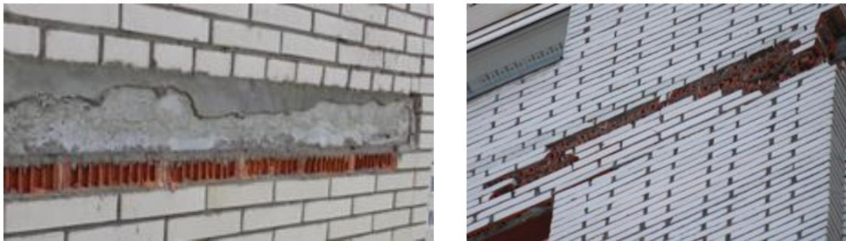
**Рисунок А.1.10.** Раздробление каменной кладки в уровне междуэтажных перекрытий с полным опиранием облицовочного слоя (с выпуском плит перекрытий или с металлическими уголками) из-за отсутствия горизонтальных деформационных швов
