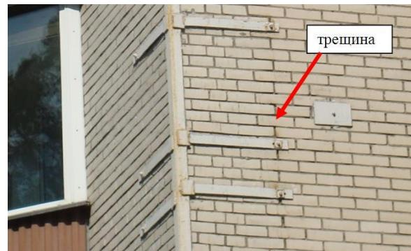
**Рисунок Б.1.** Укрепление участков облицовочного слоя с трещинами металлическими обоймами
