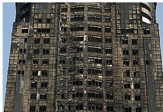
**Рисунок В.11.** Возгорание фасада вследствие применения горючих ветровлагозащитных мембран и композитных облицовочных кассет
