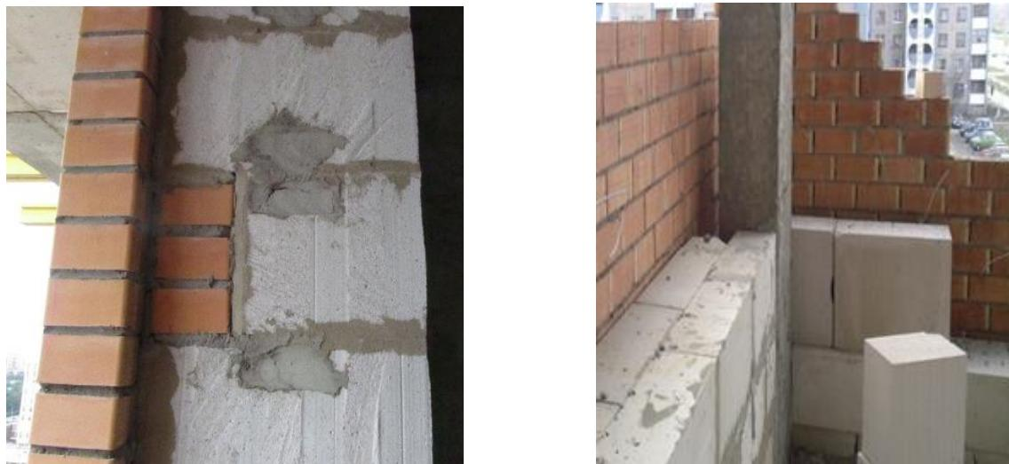
**Рисунок А.2.8.** Отсутствие вентилируемой воздушной прослойки между облицовочным слоем и внутренним слоем из газобетонных блоков
