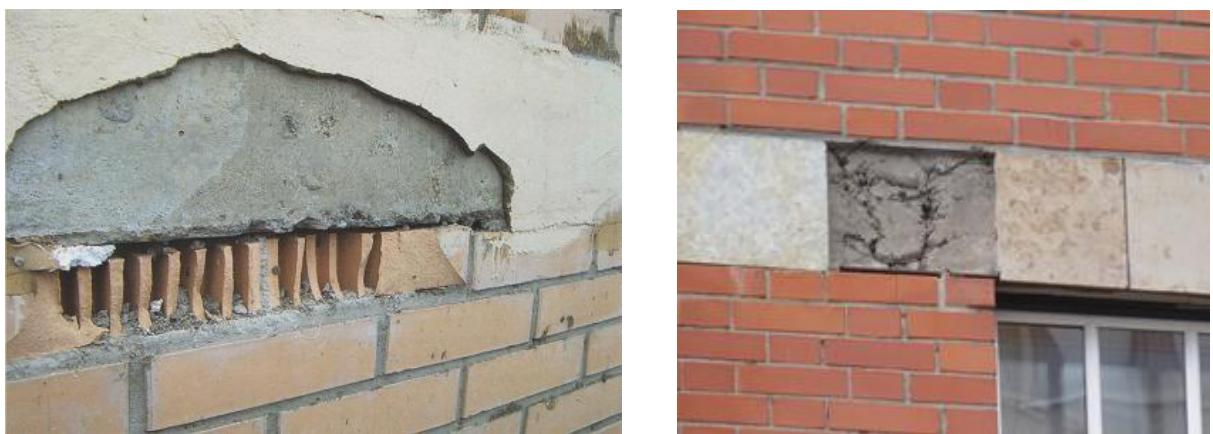
**Рисунок А.1.12.** Отслоение штукатурки и декоративной облицовочной плитки с торцов монолитных железобетонных перекрытий с полным опиранием облицовочного каменного слоя
