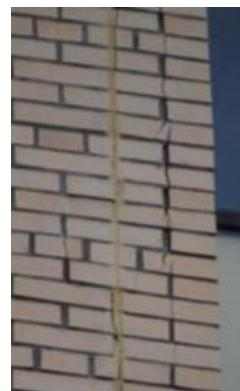
**Рисунок Б.3.** Прорезка вертикальных деформационных швов не на всю толщину облицовочного каменного слоя
