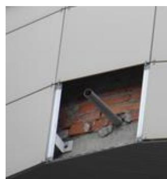
**Рисунок В.4.** Локальное удаление керамогранитной плитки с целью устройства водоотвода с лоджии
