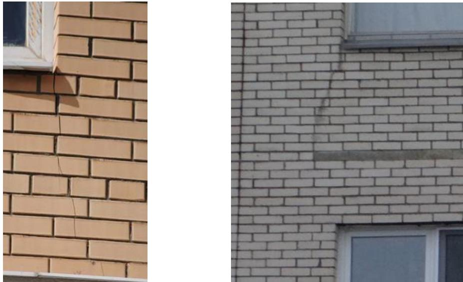
**Рисунок А.1.6.** Вертикальные и наклонные трещины на прямых участках стен в угловых зонах оконных проемов вследствие различных деформаций кладки в межоконных поясах и простенках и отсутствия ее армирования
