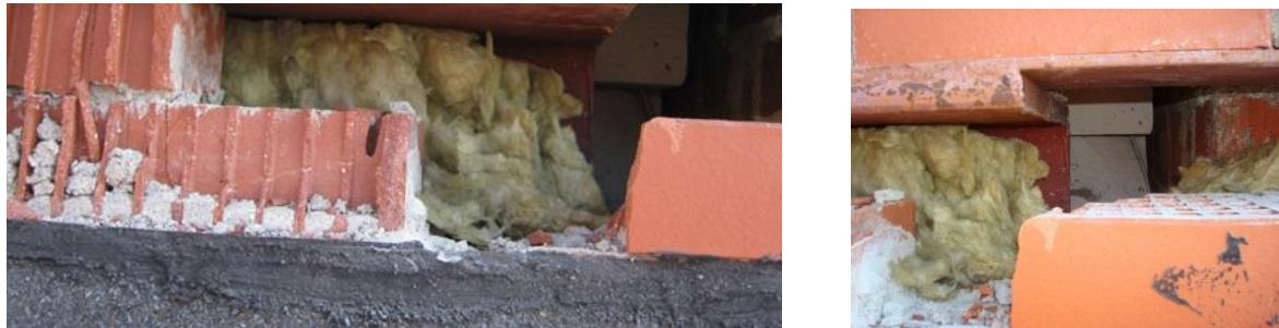
**Рисунок А.2.6.** Некачественный монтаж слоя теплоизоляции
