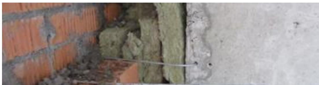
**Рисунок А.2.5.** Ненадежное крепление лицевого каменного слоя к внутренней железобетонной стене с помощью гибких связей
